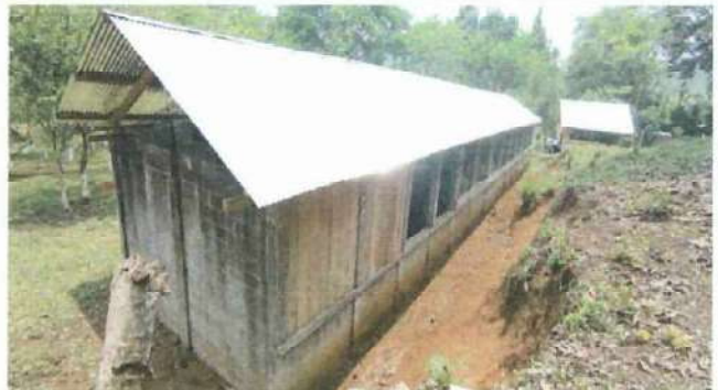
Foto 4: Reparacion de repello y sernido de paredes (afuera)
