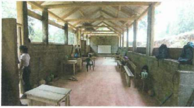
Foto1: ESTRUCTURA DE TECHO
