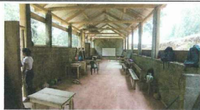
Foto 5: Sustitucion de piso
