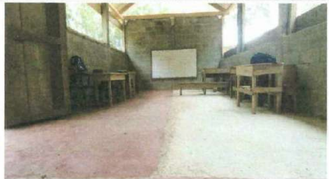
Foto 2: Reparacion de repello y sernido de paredes (adentro)
