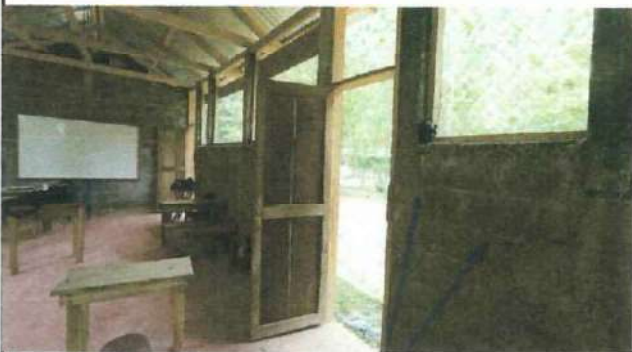
Foto 3: Sustitucion de puertas y ventanas
